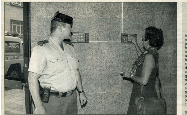
Los Nuevos Juzgados ya cuentan con dos aparatos instalados./J.GREGORIO
